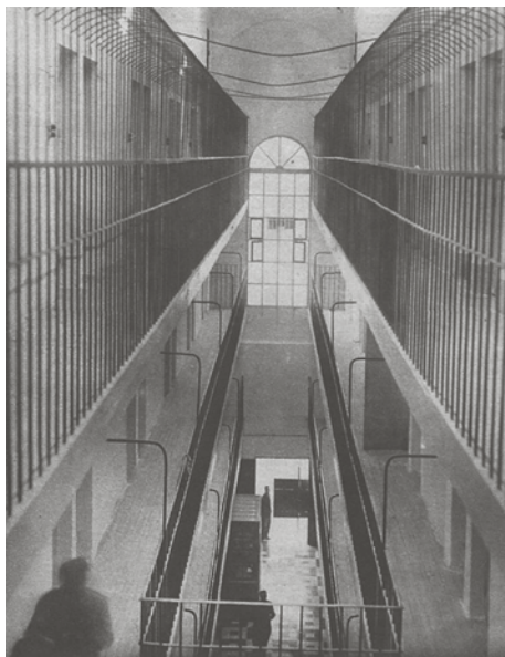
Imagen 3. Aspecto de una de las naves de la antigua prisión de mujeres de Alcalá de Henares tras su reconversión en Casa de Trabajo para Vagos y Maleantes
